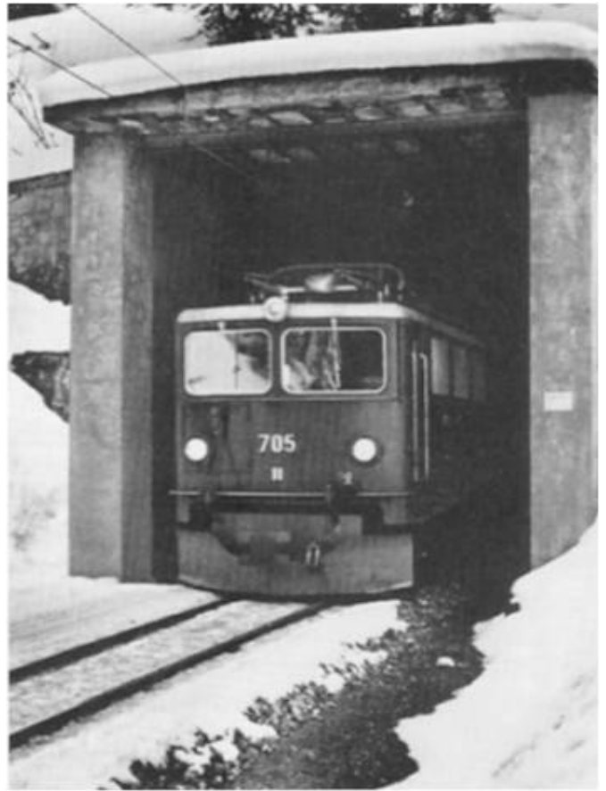
Durch die Züge gesteuertes Tor des Rugnux-Tunnels
