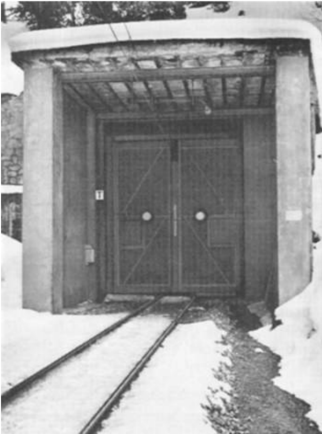
Durch die Züge gesteuertes Tor des Rugnux-Tunnels
